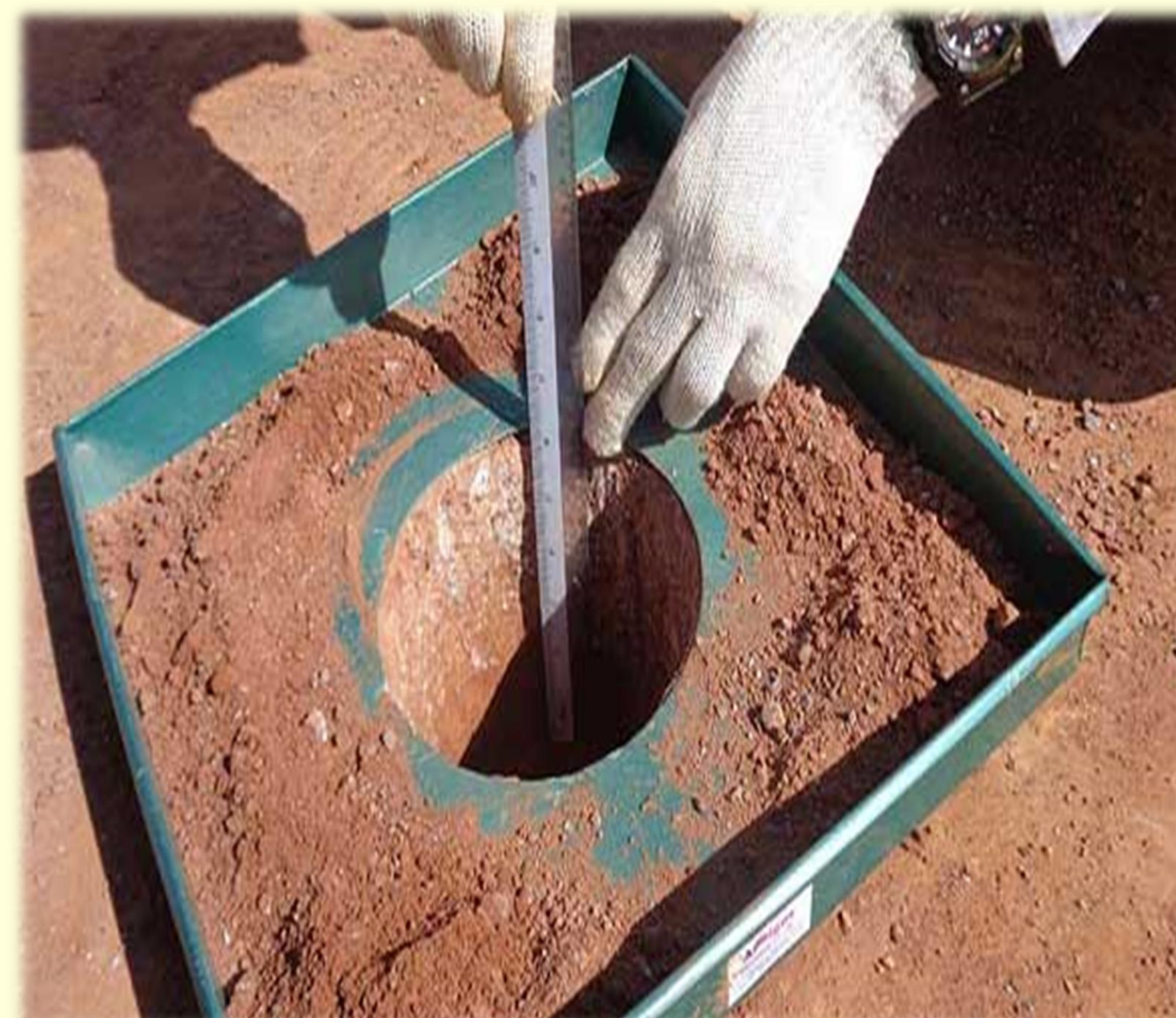
کنترل عملیات خاکی
