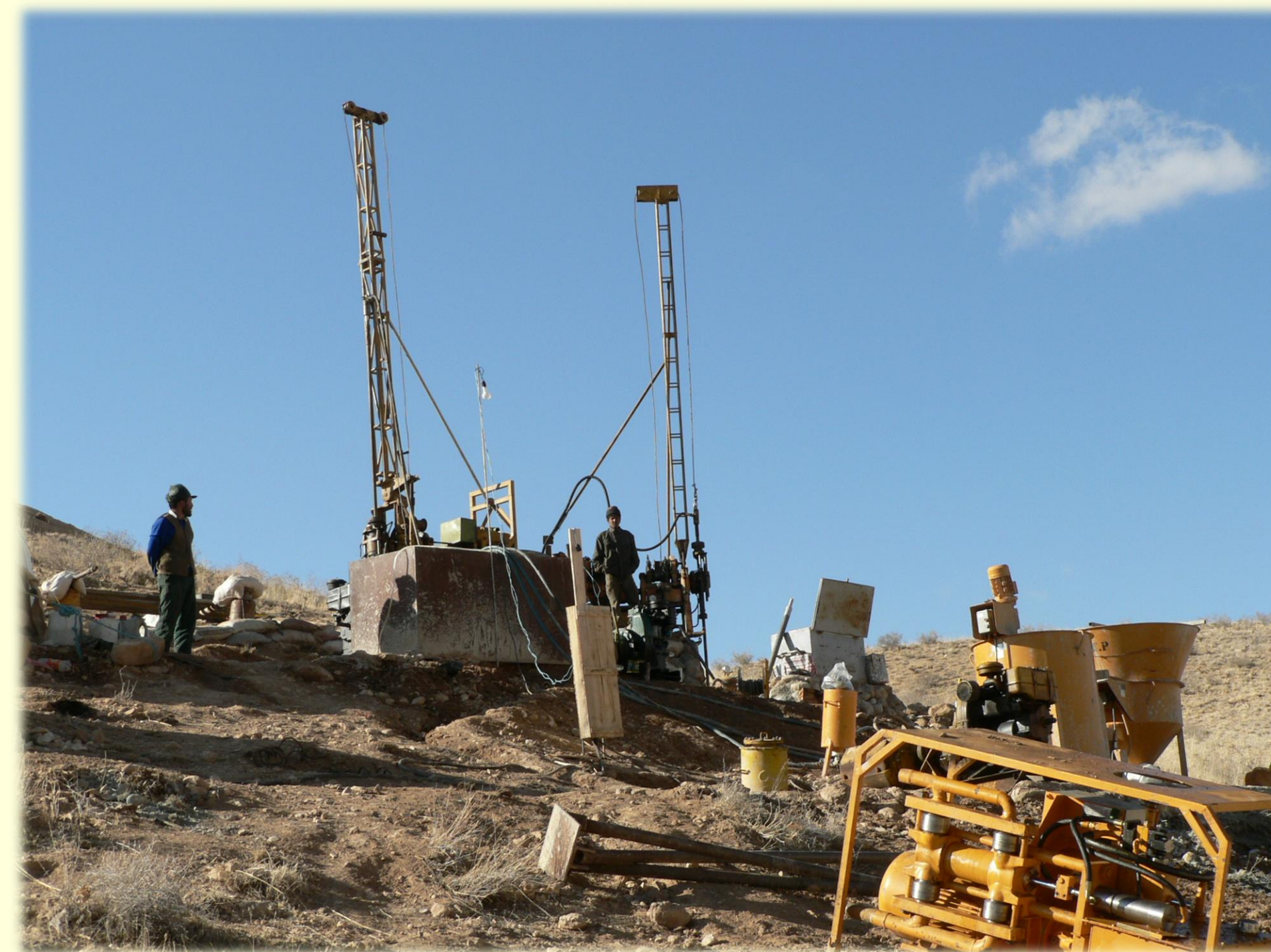
حفاری و تزریق تحکیمی و آزمایشی
