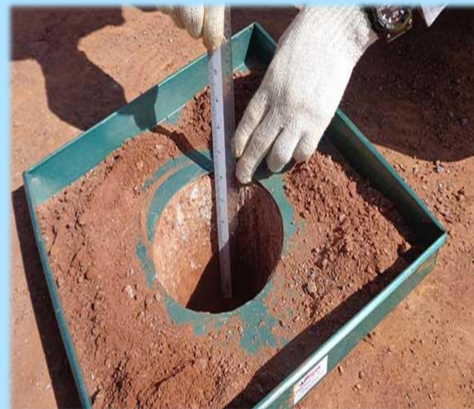
کنترل عملیات خاکی
