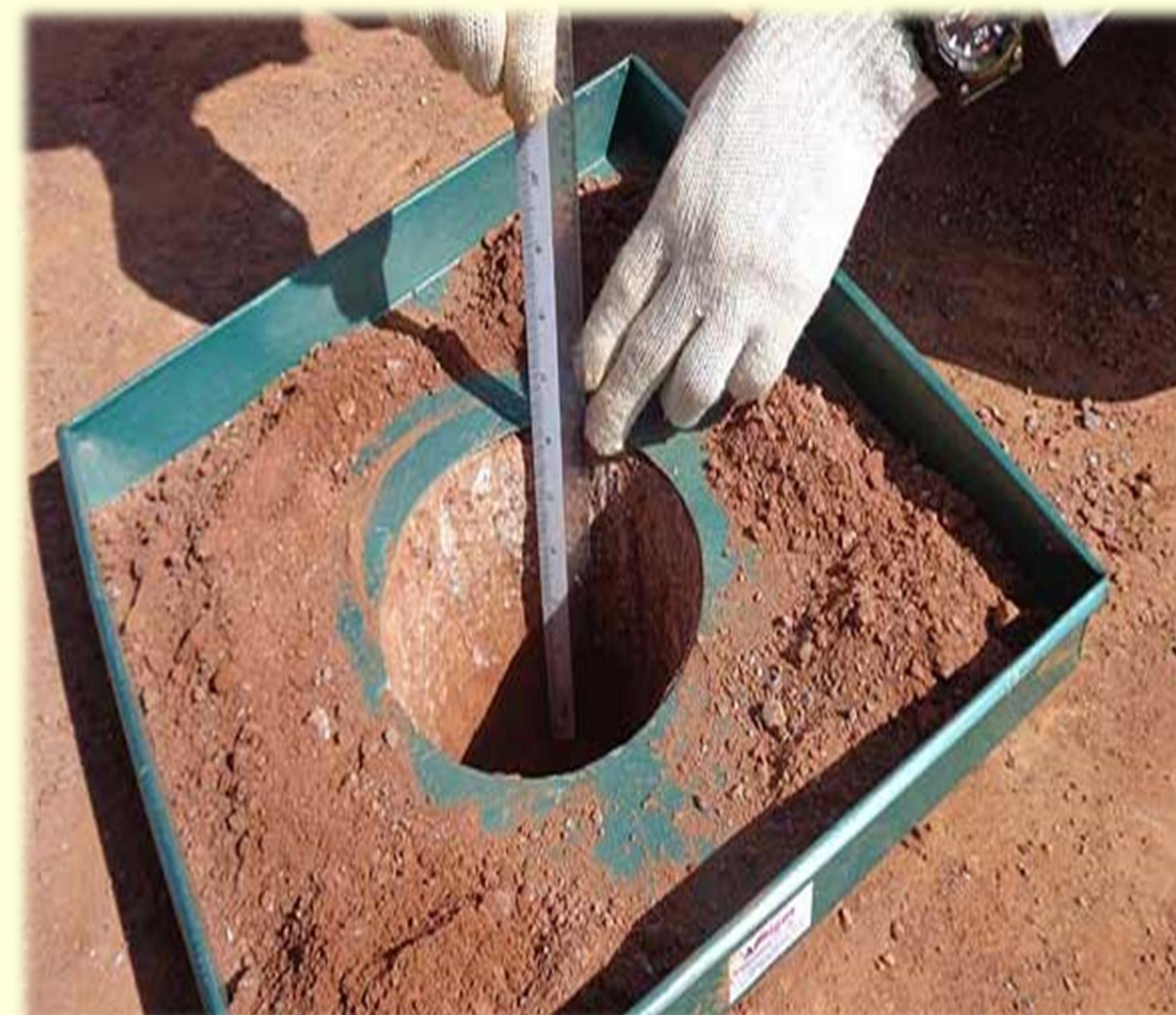
کنترل عملیات خاکی
