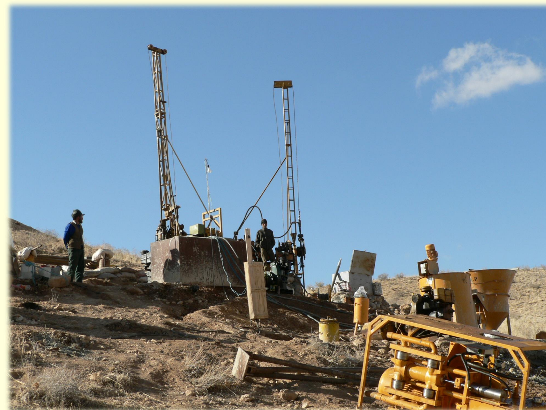
حفاری و تزریق تحکیمی و آزمایشی
