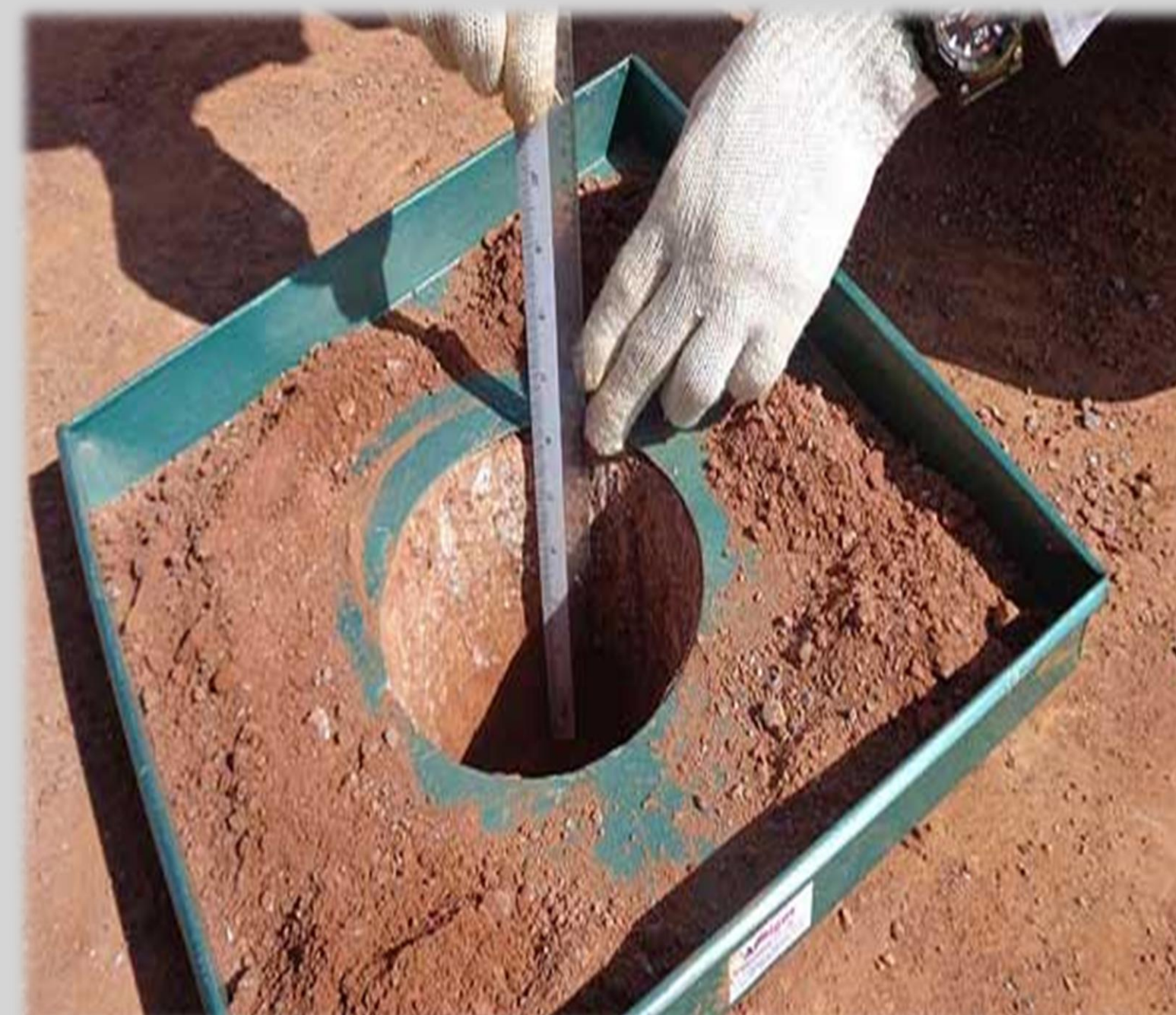
کنترل عملیات خاکی
